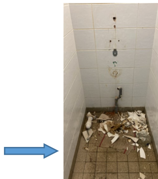
Photo prise à cluny le 29 avril 2024 lors de travaux
